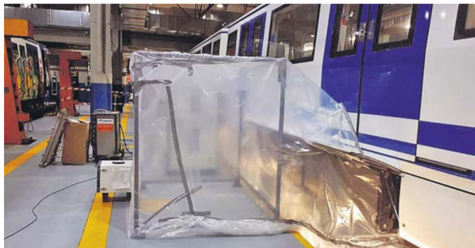
Labores de desamiantado en uno de los vagones del suburbano. METRO DE MADRID
