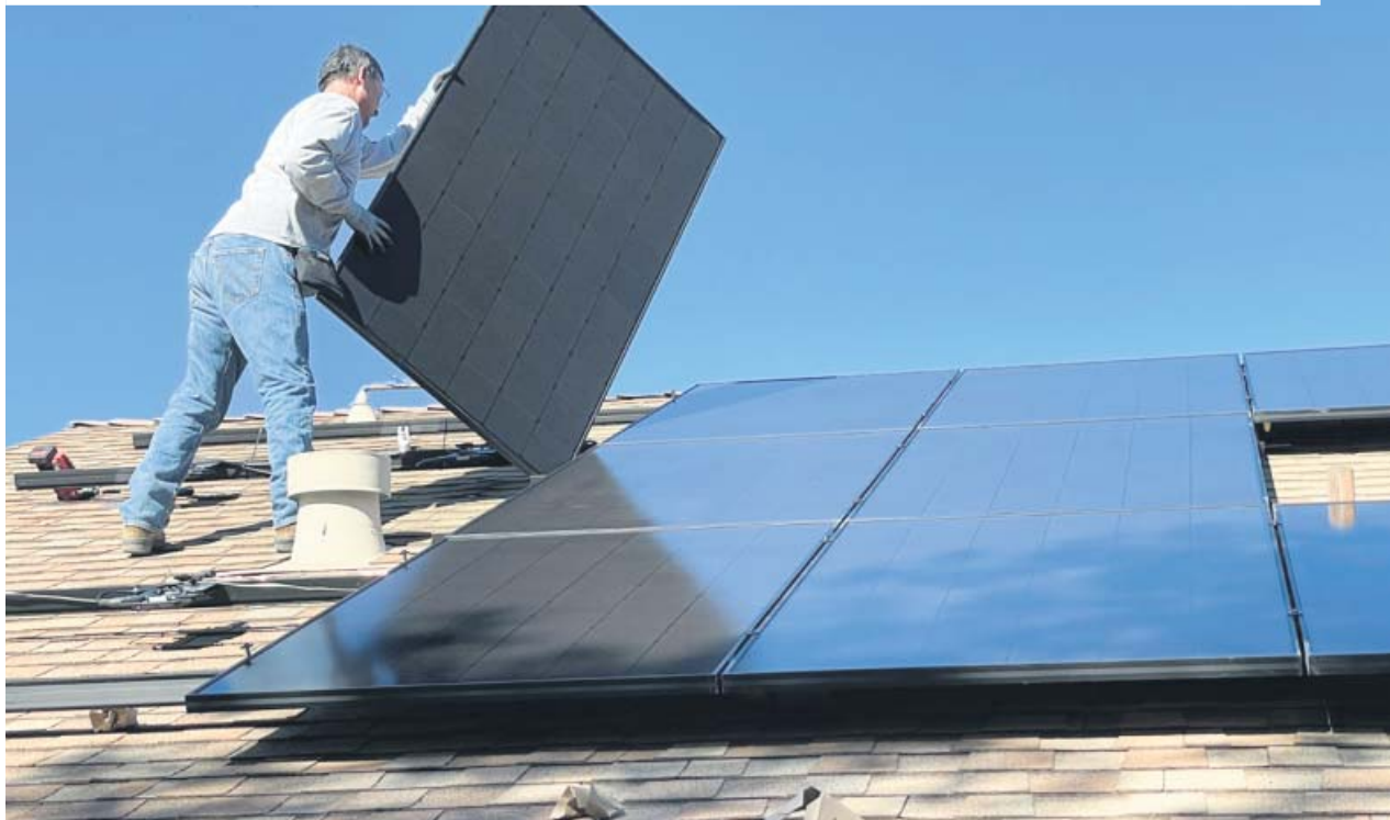
Un hombre coloca placas solares en un edificio para generar su propia energía.
