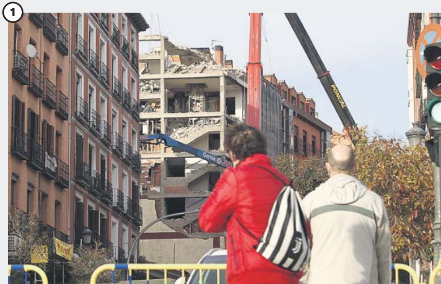
Finaliza la demolición controlada del número 98 de la calle Toledo
