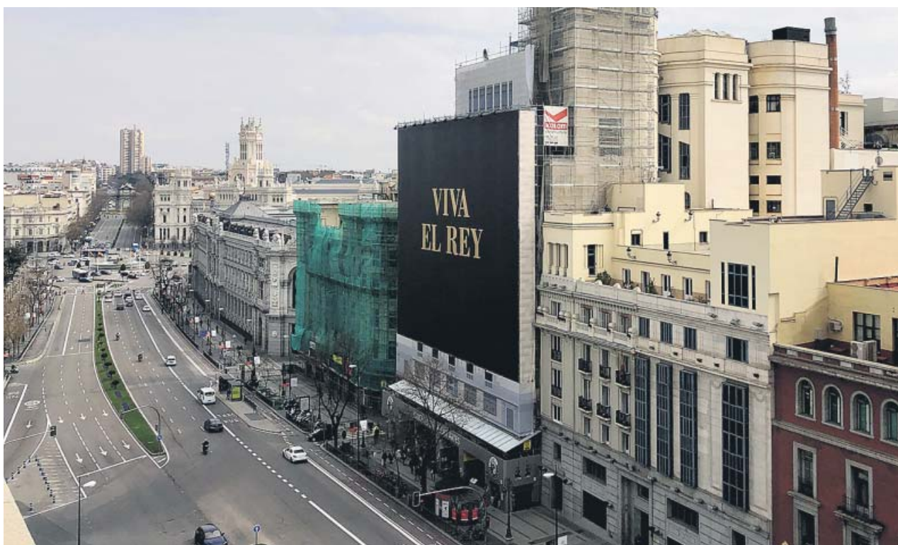
Tramo de la calle Alcalá que será objeto de una reforma integral. JORGE PARÍS
