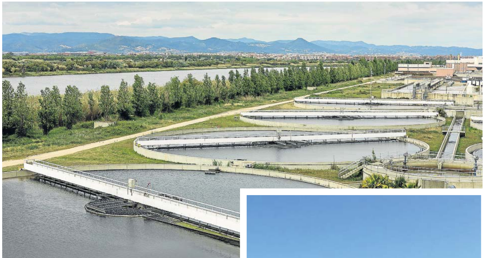
La inyección de agua regenerada de la ecofactoría del Baix Llobregat mejora la calidad de los acuíferos del delta del río. AGBAR
