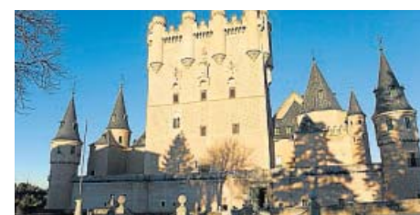
SEGOVIA. Fecha de ingreso: 1985. Motivo: Obras que abarcan desde la época romana hasta el siglo XVI. Monumento ppal.: El Acueducto. GTRES
