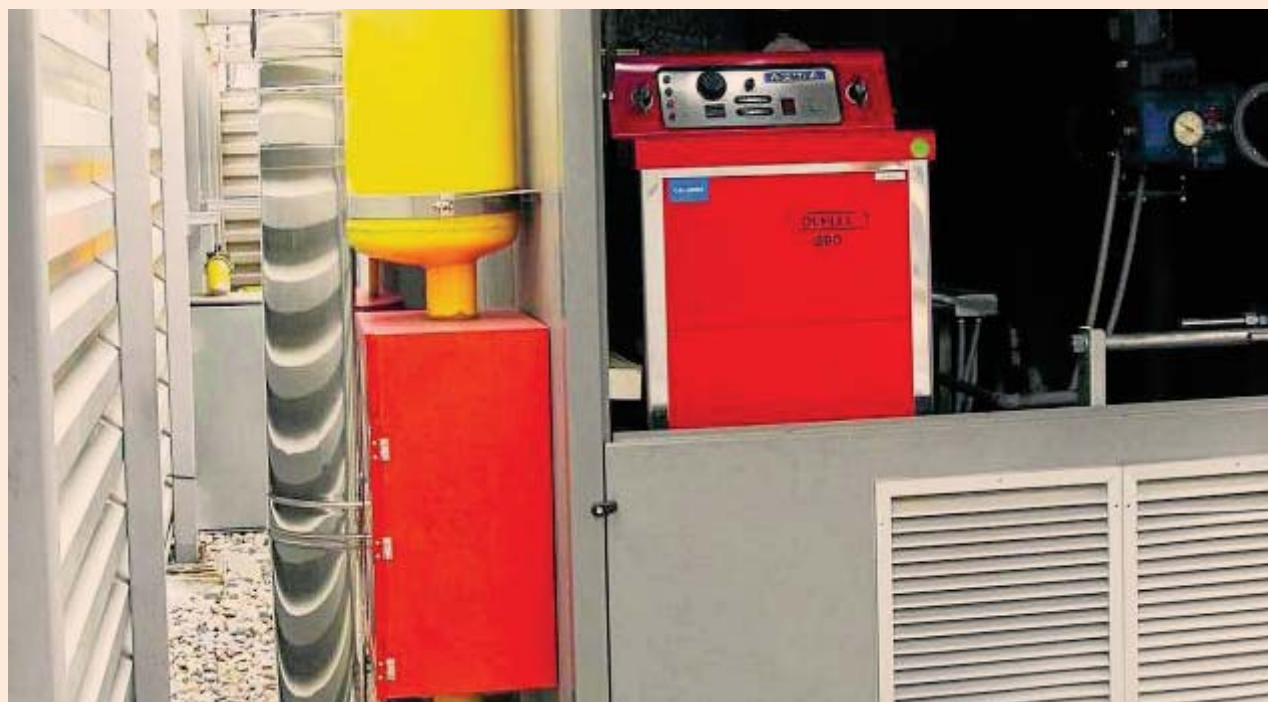
El control del consumo de energía es mucho más eficaz cuando se dispone de una caldera individual.
