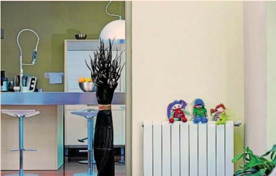
El ahorro en el consumo está muy relacionado con el sistema de calefacción instalado. ARCHIVO
