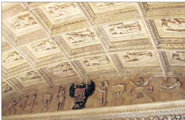
La bóveda de la Sala Capitular tras su restauración.
