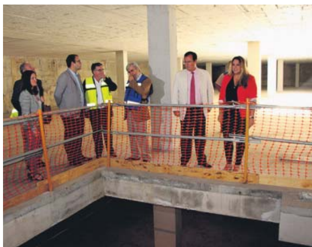
Cabrera (2d) en una visita a las obras, ayer. AYTO. SEVILLA
