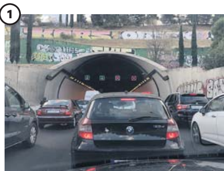
Túnel del Pardo, en la M-40 (Madrid) La M-40 es una de las zonas más transitadas de Madrid y es especialmente peligrosa en el túnel de El Pardo, debido a la concentración de vehículos y la reducida visibilidad.
