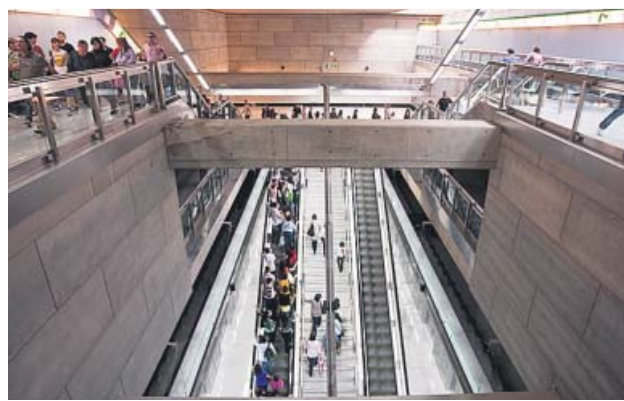
Interior de una de las estaciones del metro de Sevilla.
