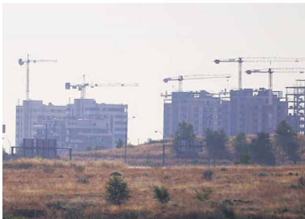
Vista de una serie de edificios en construcción. JORGE PARIS
