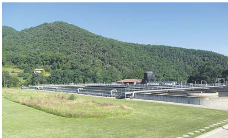
Depuradora de La Garrotxa (Girona). ARCHIVO
