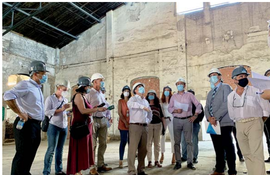
El alcalde de Sevilla, Juan Espadas, visitó ayer los trabajos que se están desarrollando en la antigua fábrica de vidrio La Trinidad, cuya primera fase finalizará este verano. AYTO. SEVILLA
