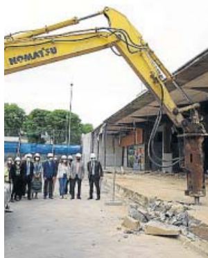
Visita ayer del alcalde al inicio de las obras. AYTO.
