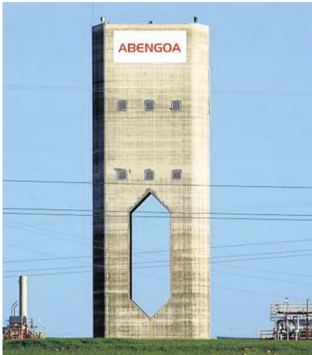
Planta ubicada en Sanlúcar la Mayor. ABENGOA
