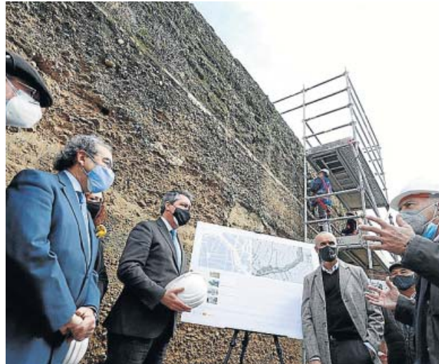
El alcalde, Juan Espadas, en el inicio de los trabajos. AYTO.
