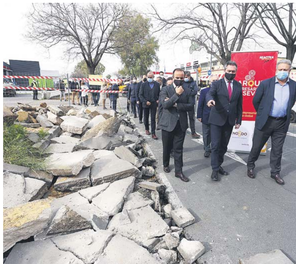
Visita del alcalde, Juan Espadas (centro), a las obras de la calle Aviación. AYTO.
