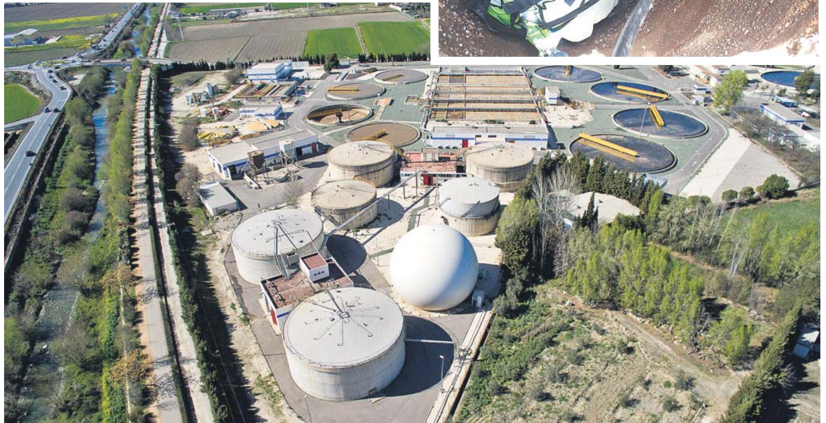
Arriba, un operario realiza labores de mantenimiento de redes. Debajo, la Biofactoría Sur en Granada, referente en economía circular de aguas en Europa. HIDRALIA
