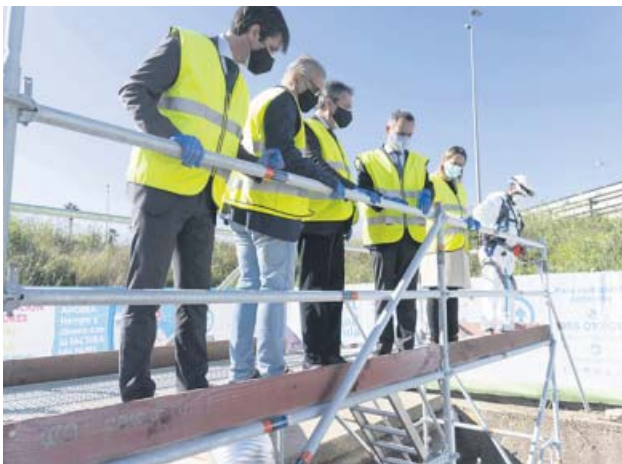
Espadas visitó ayer el colector del Puerto. AYTO. SEVILLA
