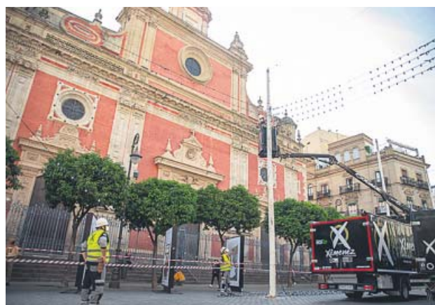
Operarios colocando luces en la plaza del Salvador. XIMENEZ
