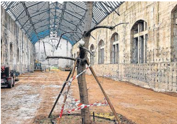
Obras en el interior de las Naves de Renfe. EMVISESA
