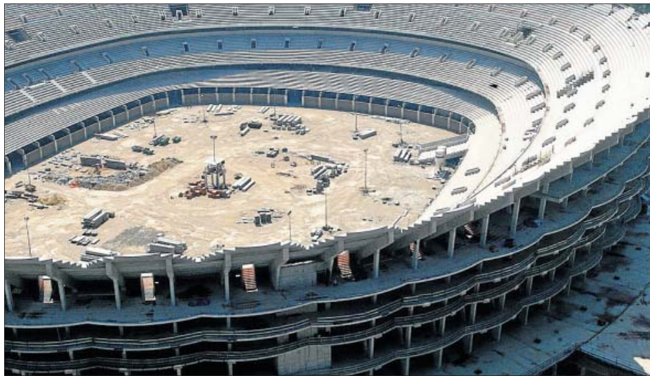
Aspecto actual del nuevo Mestalla, tras tres años y cinco meses con las obras paradas.
