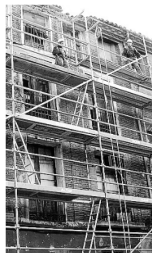
Reformas en la fachada de un edificio de Madrid. ARCHIVO
