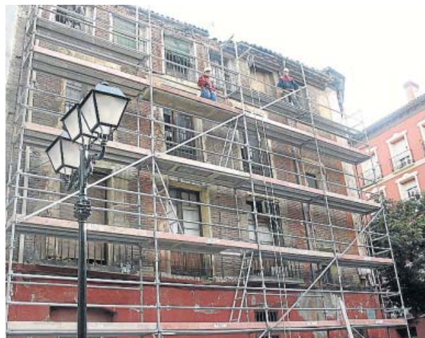
Un edificio antiguo en plena labor de rehabilitación.
