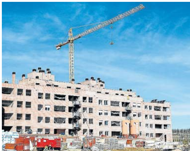
Un bloque de pisos en construcción.
