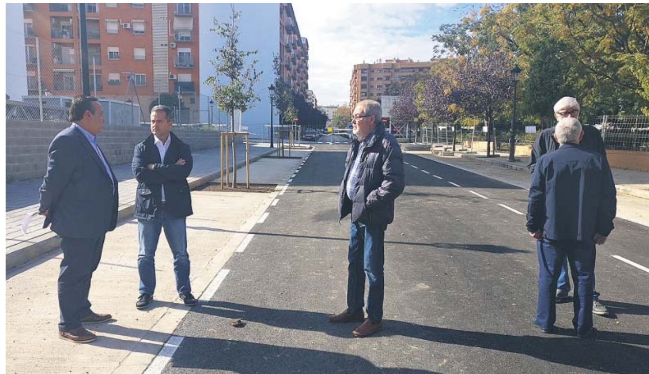
El concejal Vicent Sarrià (izda.) visitó ayer la zona en la que se han efectuado las obras.
