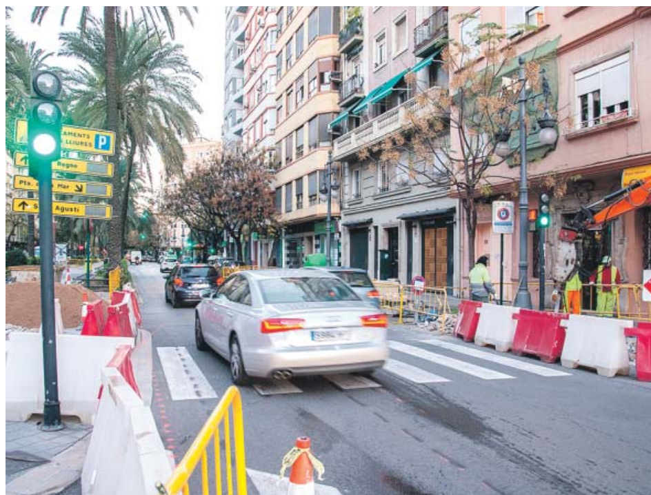
Estado actual de las obras de construcción del carril bici en la avenida Reino de València.
