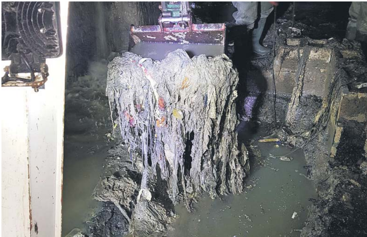
Labores de extracción de las toneladas de residuos acumulados en el colector norte de València.
