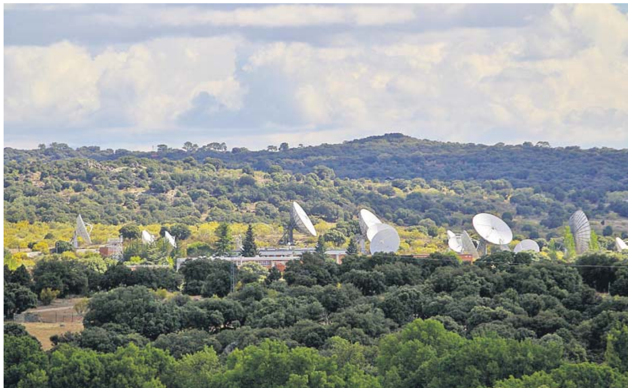
Vista actual de la estación de la NASA de Fresnedillas desde la carretera M-532 en dirección a Fresnedillas. FOTOS: JORGE PARÍS
