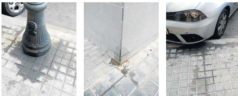
En algunos comercios, como el de la foto superior, en el barrio de l'Hort de Senabre, se han colocado letreros apelando al civismo de los dueños de perros para que estos no orinen en las fachadas. Sobre estas líneas, farolas, aceras y hasta vehículos totalmente impregnados de orín.
