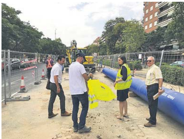
La concejala Elisa Valía visita las obras en Jacinto Benavente.
