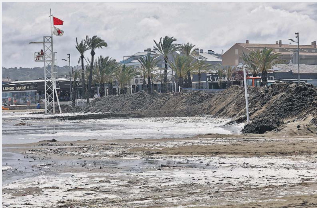
Barrera levantada en la playa de Xàbia para proteger la línea de costa de los efectos del temporal. J. C. CÁRDENAS / EFE
