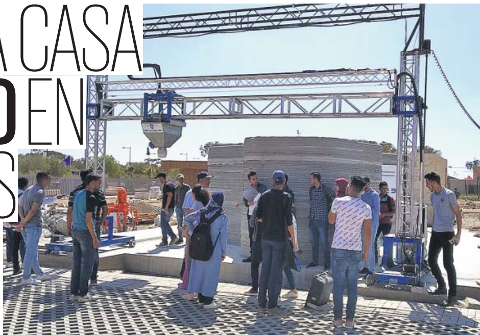
La impresora 3D de la empresa valenciana, en el momento de la construcción de la casa.
