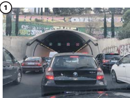
Túnel del Pardo, en la M-40 (Madrid) La M-40 es una de las zonas más transitadas de Madrid y es especialmente peligrosa en el túnel de El Pardo, debido a la concentración de vehículos y la reducida visibilidad.
