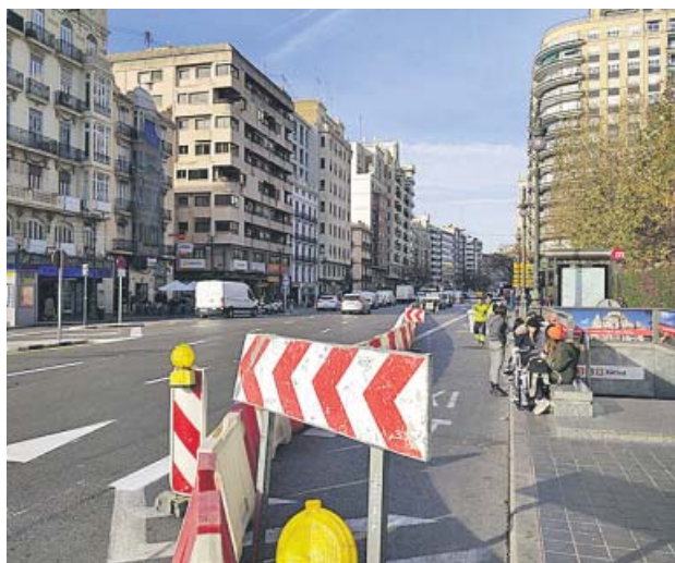
La zona de obras, junto a un acceso al metro de Xàtiva.
