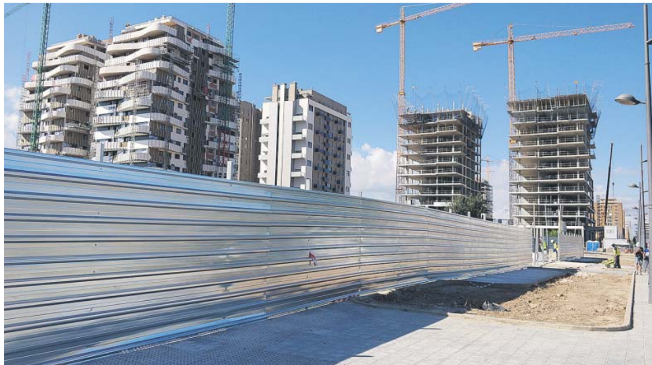
La parcela en la que se levantará el nuevo centro educativo de València, junto a la avenida Antonio Ferrandis.
