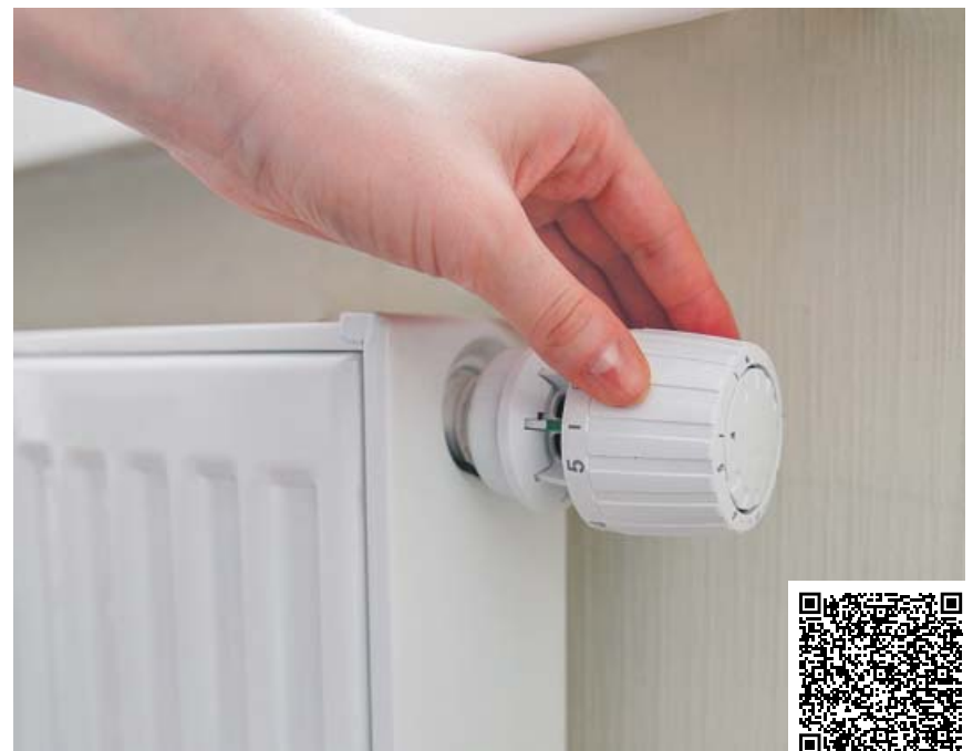
Instalar válvulas termostáticas es una de las opciones para cumplir con la nueva normativa. ARCHIVO
