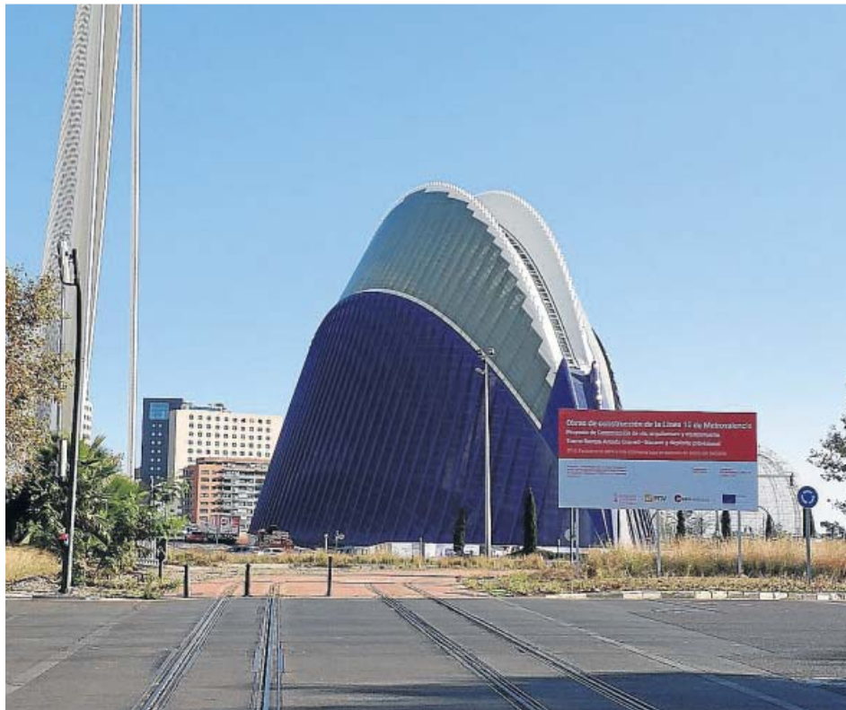
Cartel colocado en la rotonda de la Ciudad de las Ciencias anunciando el inicio de las obras.
