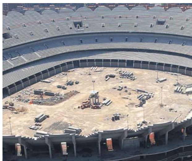
El nuevo Mestalla, una obra parada desde hace años. ARCHIVO
