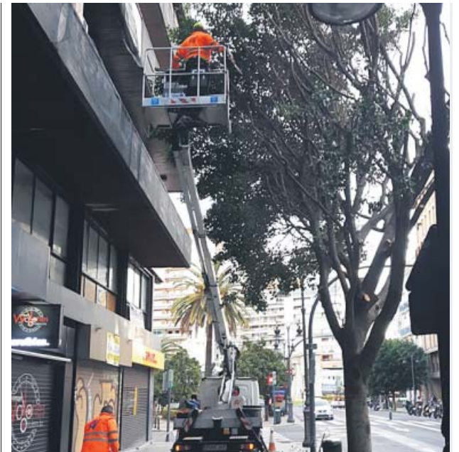
Operarios, ayer, en los trabajos junto a la Porta de la Mar.
