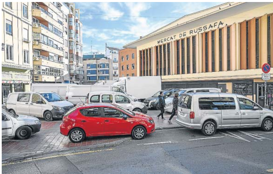
Estado en el que se encuentra actualmente la zona, llena de coches estacionados. PILAR ALBELDA / AYTO. VLC
