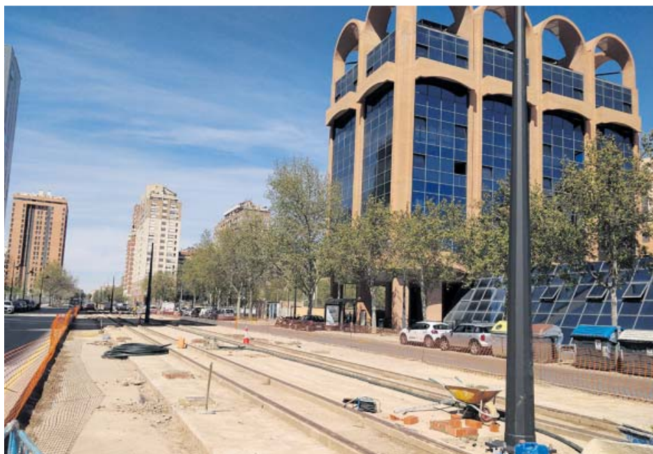
Aspecto que presentaban ayer las obras de colocación de los postes para las catenarias.
