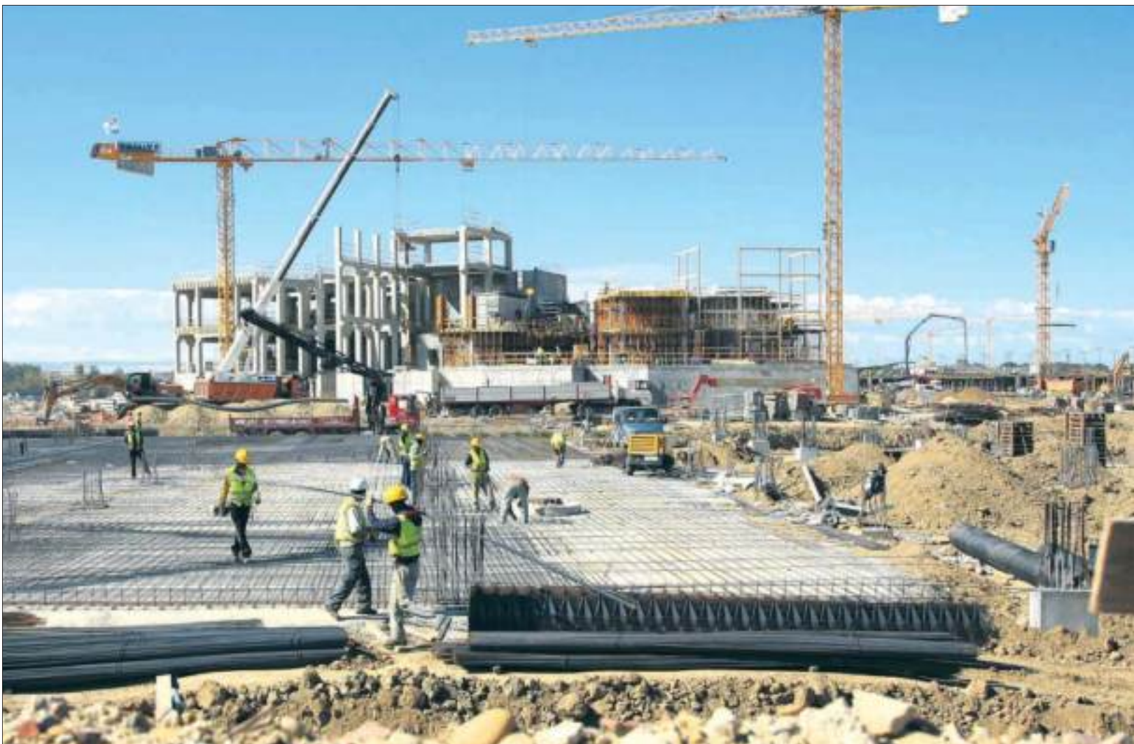
LA EXPO VA TOMANDO FORMA Son ya casi 2.000 los trabajadores que en la actualidad desarrollan jornadas de 10 horas en las obras de la Expo, cuyos edificios van tomando ya forma, en medio de un mar de vigas y de grúas. Los zaragozanos ya pueden visitar las obras en trayectos guiados. FABIÁN M. SIMÓN
